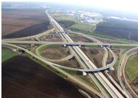
2. Węzeł drogowy na południe od Wrocławia w gminie Kobierzyce.
