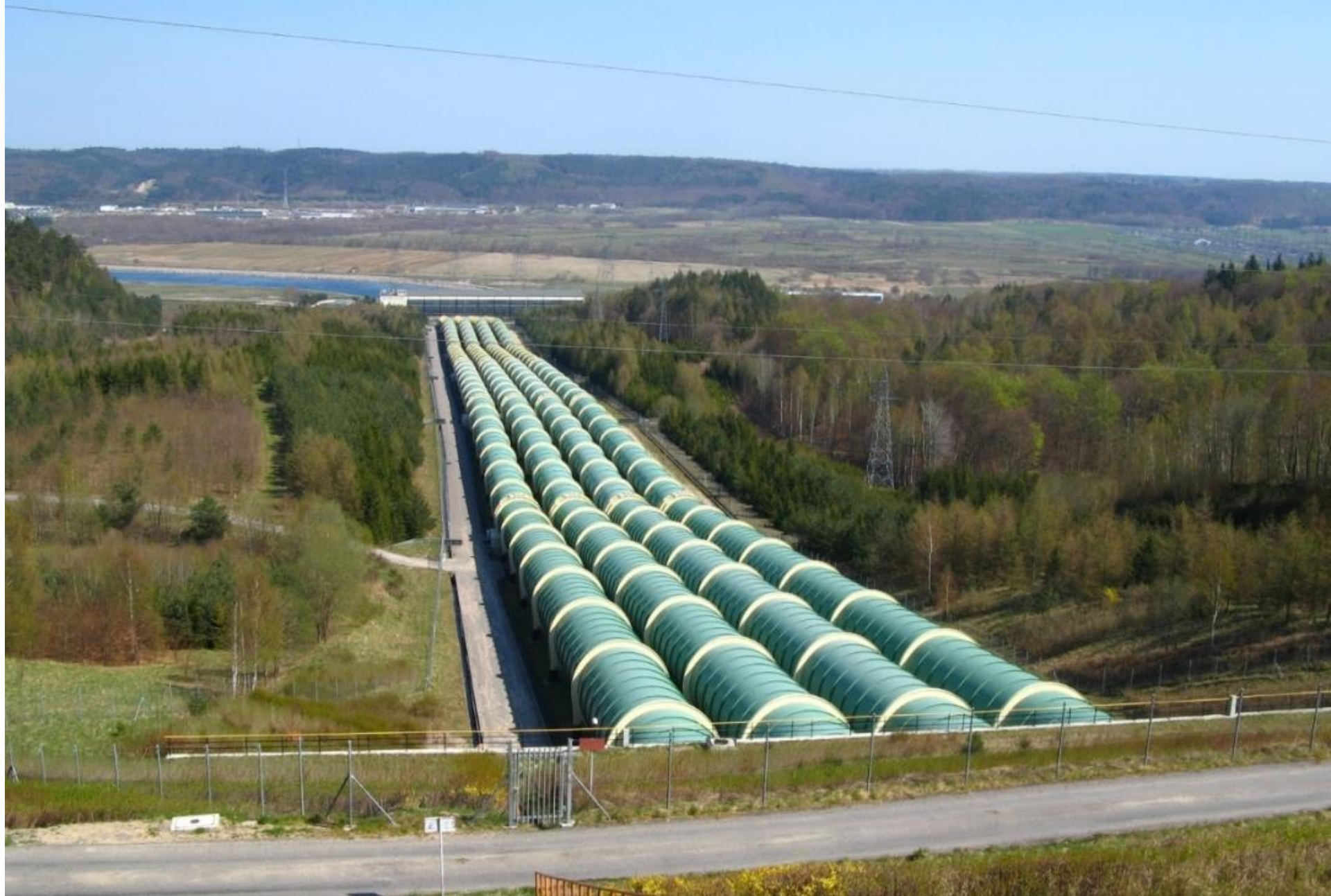
Elektrownia szczytowo-pompowa w Żarnowcu
